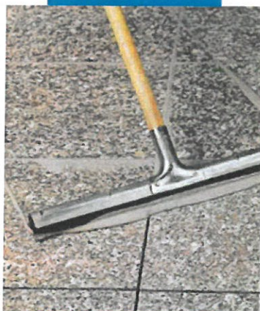
Spoimowanie wyrównanego i wypolerowanego granitu gumową raklą
