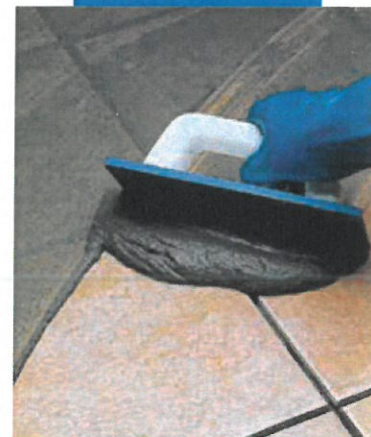
Spoinowanie płytek gumową pacą
